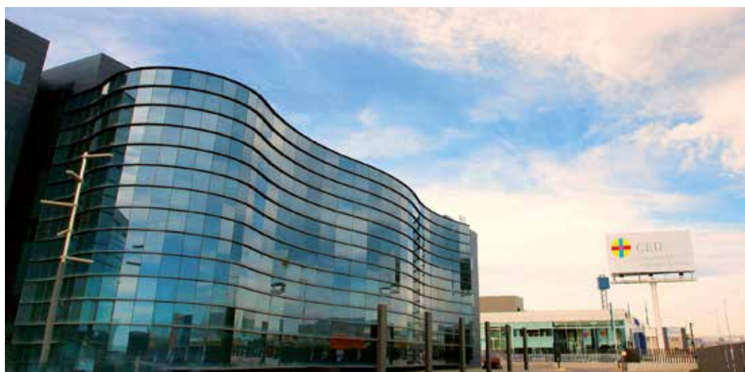
Instalaciones Universidad CEU-Cardenal Herrera, Castellón
